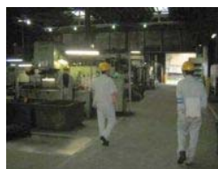
エア漏れ点検
