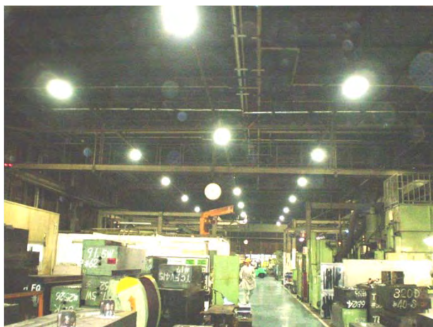
天井照明のLED化【二本松工場】
