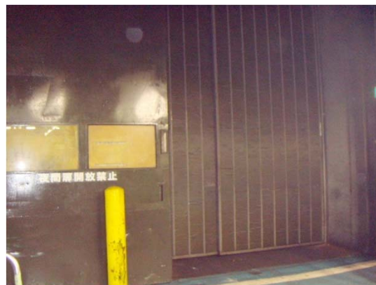
防音材施工と気密性改善
