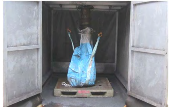
集塵ダストのフレコンバック回収 (粉じん飛散防止)
