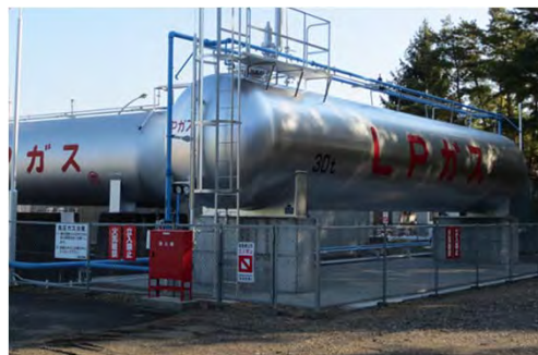
ガスタンク増設
