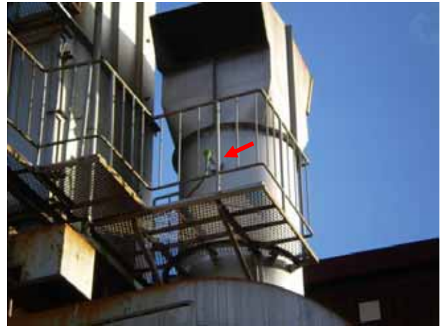
集塵機排気筒にダストモニター取り付け (9月)
