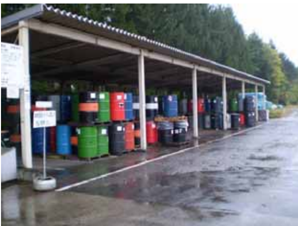
廃油、油付スケール等の廃棄物をドラム缶に分別回収し下屋に保管(11月)
