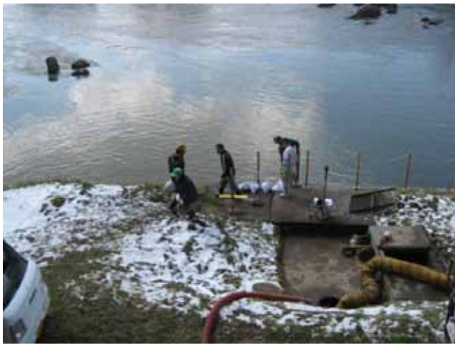
阿武隈川取水口の清掃協力(4月)
